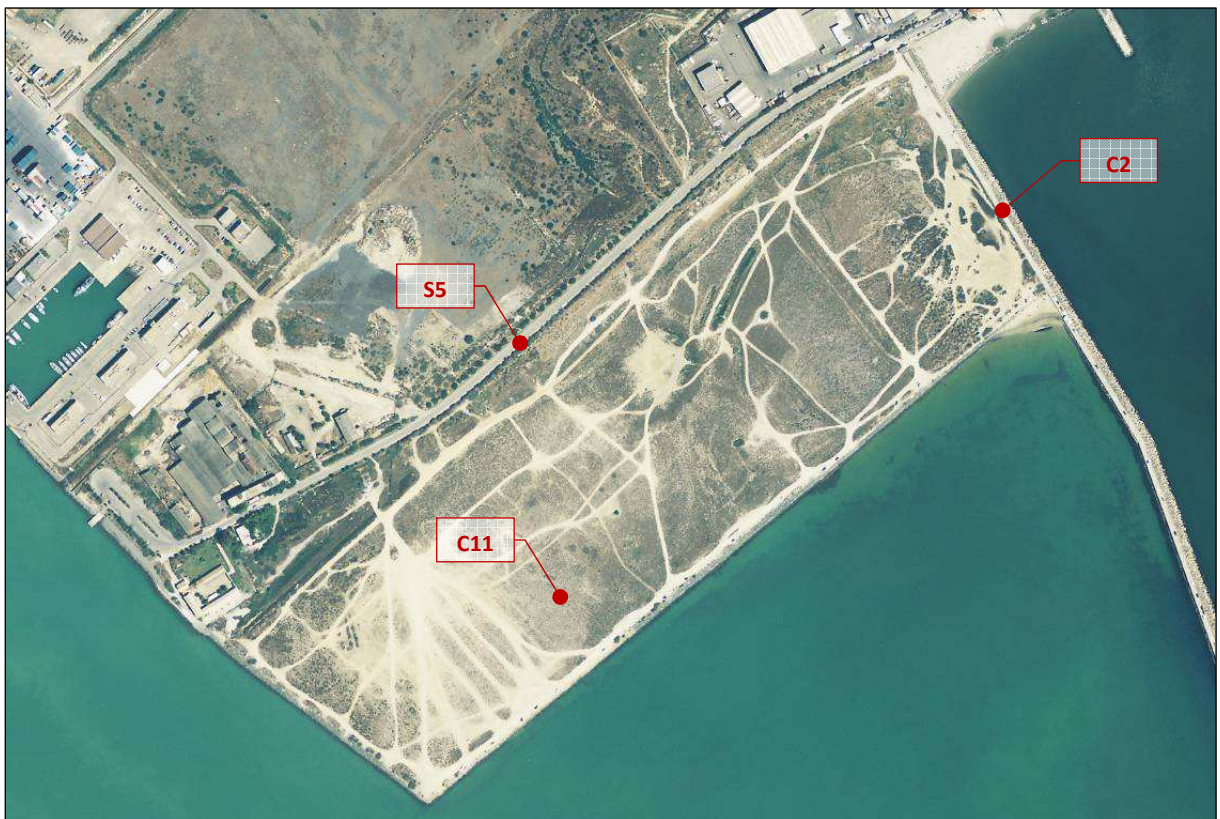
FIGURA 5 – Foto aerea con indicazione dei punti fissi S5, C2 e C11.
